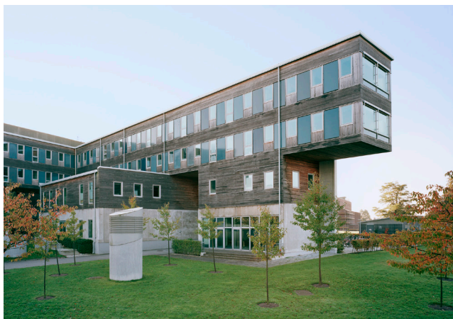
Ingvar Kamrad Designcentrum i Lund är en av Akademiska Hus fastigheter. Tack vare Energiportalen kan fastighetens energianvändning visualiseras ner på detaljnivå. Foto: Akademiska Hus
